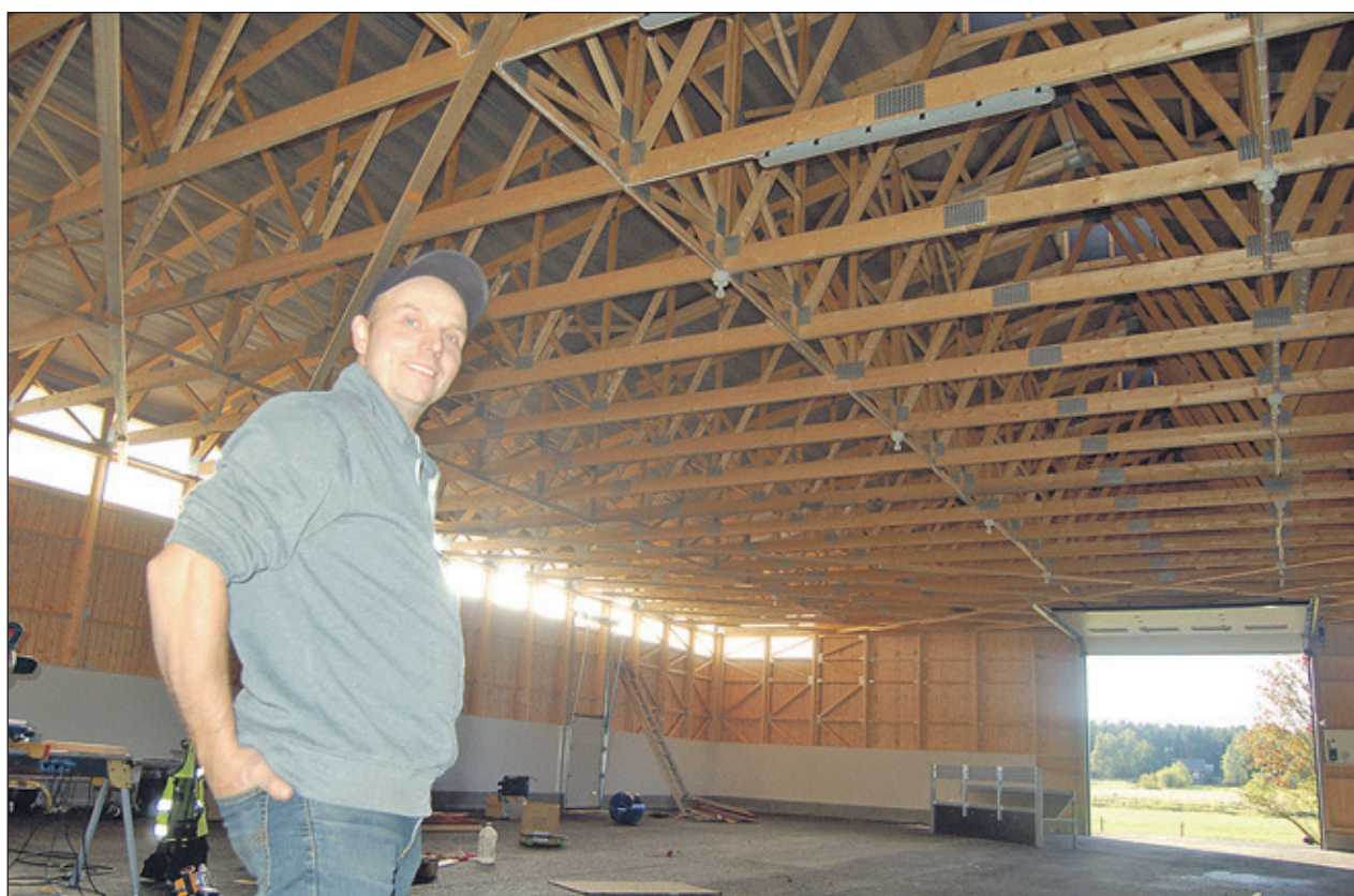
Kaj Sjögård har tillsammans med familjemedlemmarna gjort en stor del av byggnadsarbetena i den rödmålade trähallen. Fönsteryornas areal i byggnaden bör vara minst fem procent av golvytans areal, exemplifierar Sjögård.
